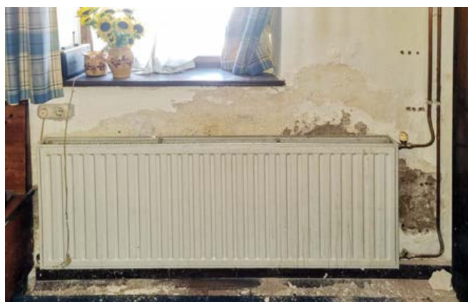
Abbildung 10+11: Vermehrte Salzausblühungen und Putzschäden sind aufgrund des „Dochteffektes“ in der Nähe des Heizkörpers sehr gut sichtbar.
