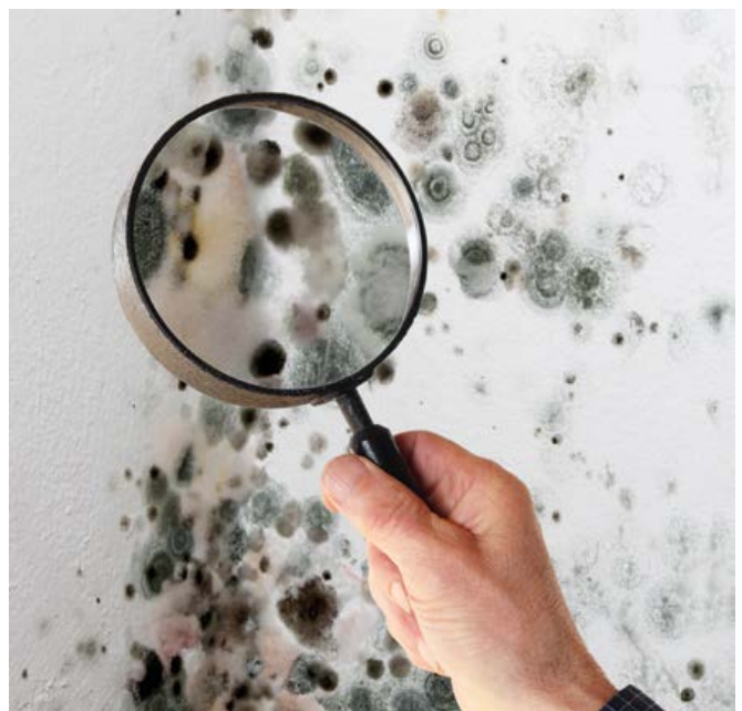
Abbildung 07: Schimmel am Mauerwerk
