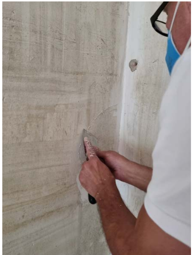
Abbildung 21-24: Entfernung von Schimmel mit Hilfe von Essigessenz.
