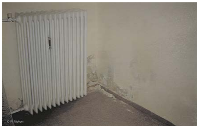
Abbildung 10+11: Vermehrte Salzausblühungen und Putzschäden sind aufgrund des „Dochteffektes“ in der Nähe des Heizkörpers sehr gut sichtbar.
