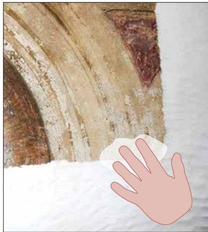
Grafik 6: Kompressen werden hier auf die von Salz beschädigten Fresken mit der Hand aufgetragen.
