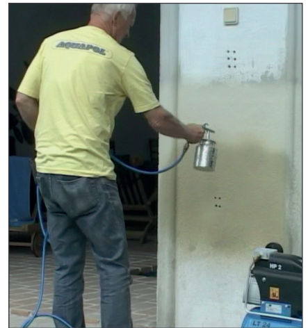
Foto 3: Die maschinelle Entsalzung von Putzen bei großen Flächen.
