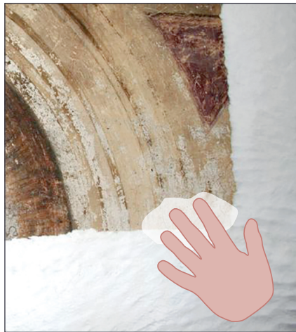
Grafik 6: Kompressen werden hier auf die von Salz beschädigten Fresken mit der Hand aufgetragen.
