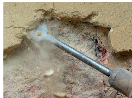
Foto 3: Entfernung des Altputzes für vollständige Trockenlegung der Mauer
