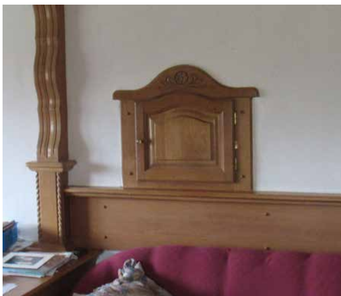
... und durch einen Lehmputz ersetzt.
